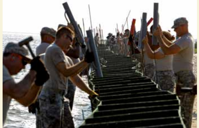
1.37 > Auch Schutzwände konnten Dauphin Island nicht retten.
