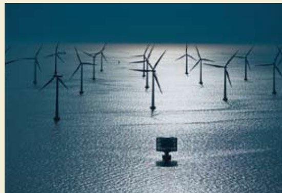
7.12 e > Windräder im Meer gibt es bereits vielerorts. Einer der größten Offshore-Windparks mit 48 Rotoren befindet sich in der Ostsee zwischen Dänemark und Schweden. Um die Energie ins schwedische Stromnetz einspeisen zu können, hat man hier eine Trafostation errichtet.
