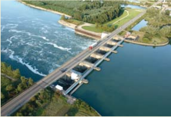
7.12 a > An mehreren Orten in Europa gibt es bereits Anlagen zur Ernte der Meeresenergie. Die älteste ist das La-Rance-Gezeitenkraftwerk bei Saint Malo in Frankreich, das bereits in den 1960er Jahren errichtet wurde. Mit einer Leistung von 240 Megawatt war es lange das größte seiner Art.
